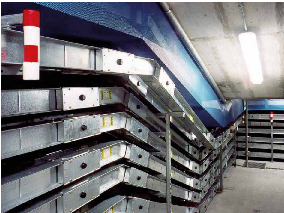
Ejemplo de distribución de alta potencia.
