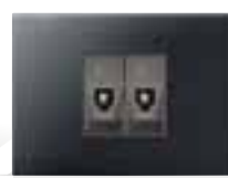
Salida de teléfono RJ11 doble
